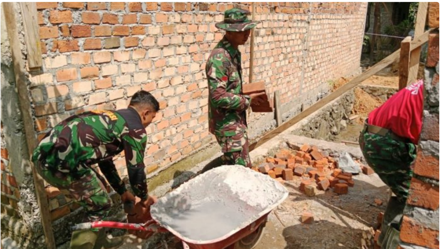
Satgas TMMD Ke- 118 Wiltas Kodim 0910/Malinau Terus Kebut Pembangunan MCK Gereja
