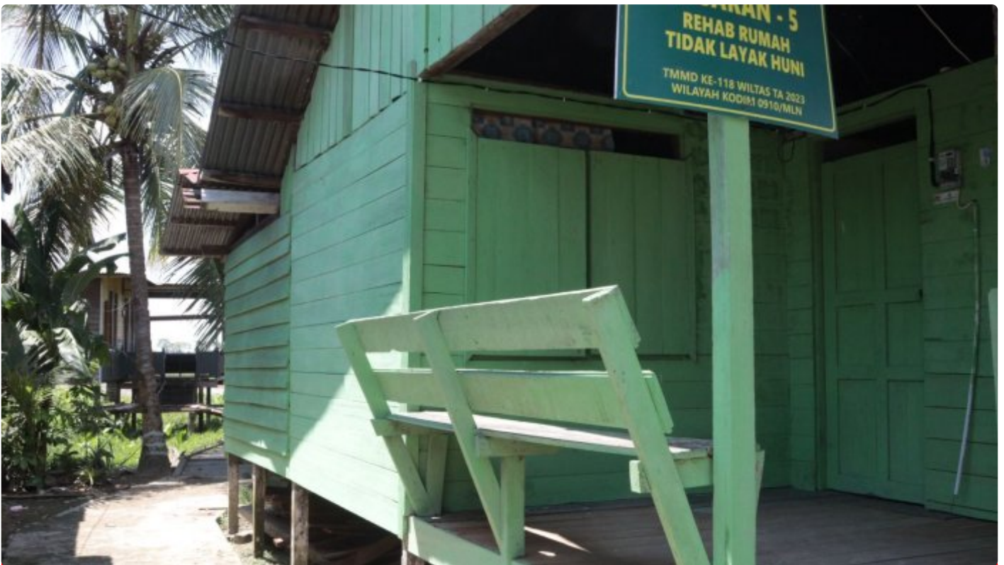
Sasaran Fisik Rehab RTLH TMMD Ke-118 Wiltas Kodim 0910/Malinau Selesai 100 Persen
