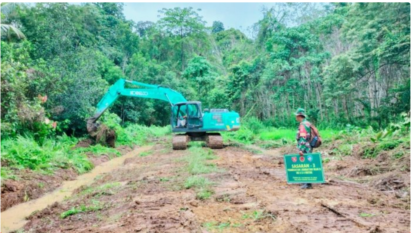
Progres sasaran fisik pembukaan badan Jalan TMMMD ke-118 Capai 31 Persen
