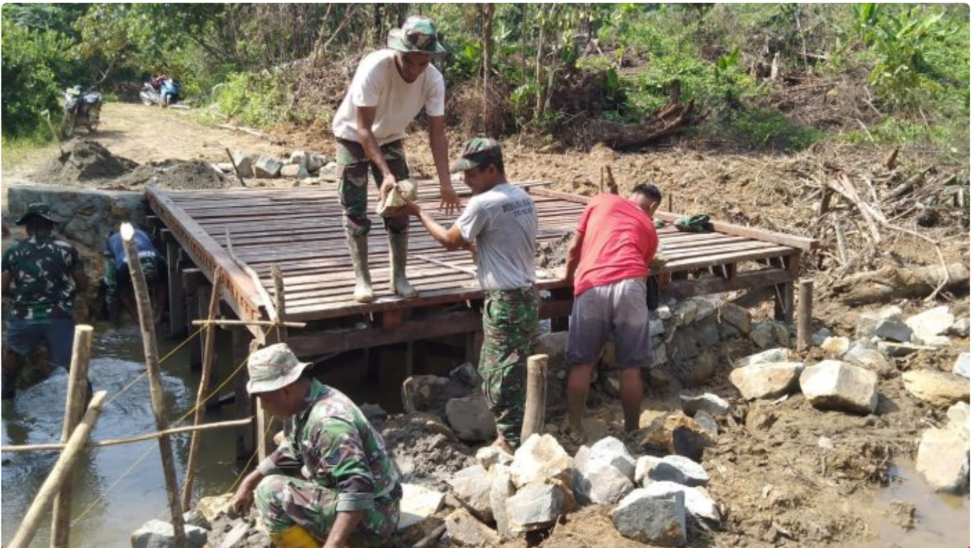
Progres Pengerjaan Jembatan TMMD Ke- 118 Wiltas Kodim 0910/Malinau Capai 65 Persen
