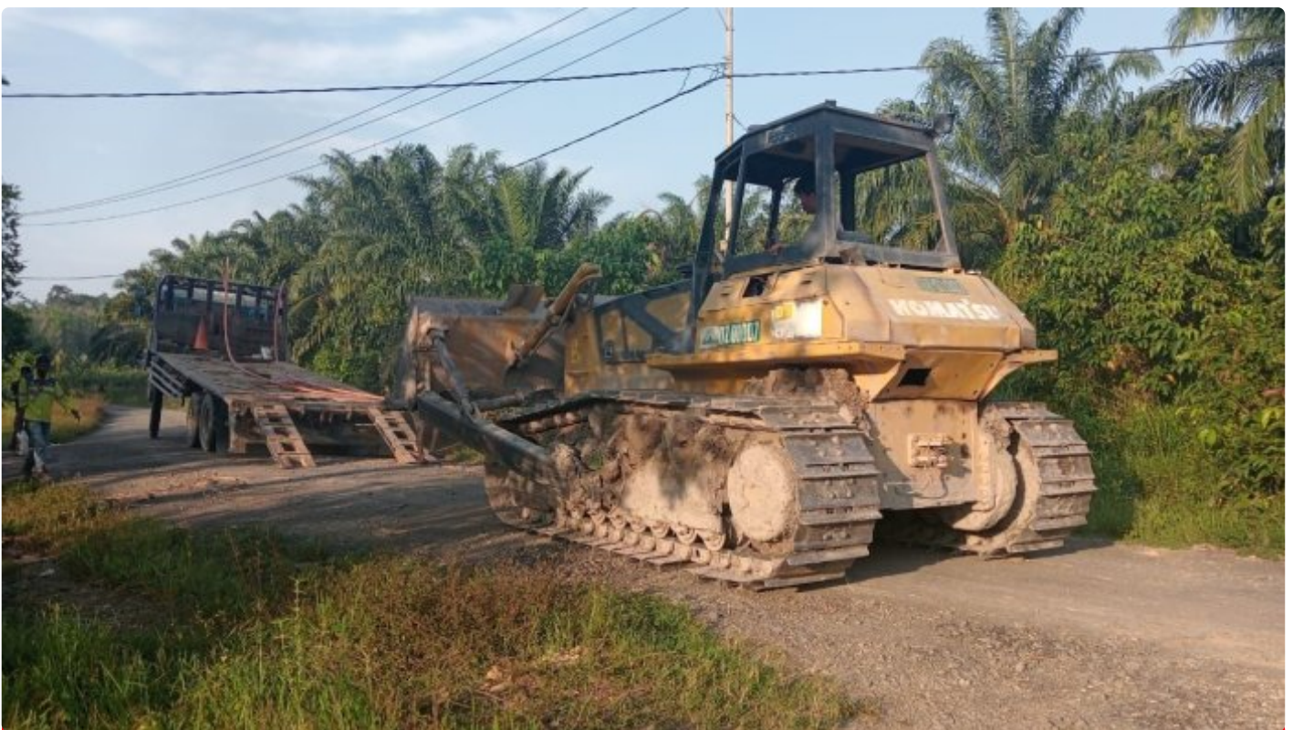
Percepat Pembukaan Badan Jalan Satgas TMMMD Ke- 118 Turunkan Bulldozer
