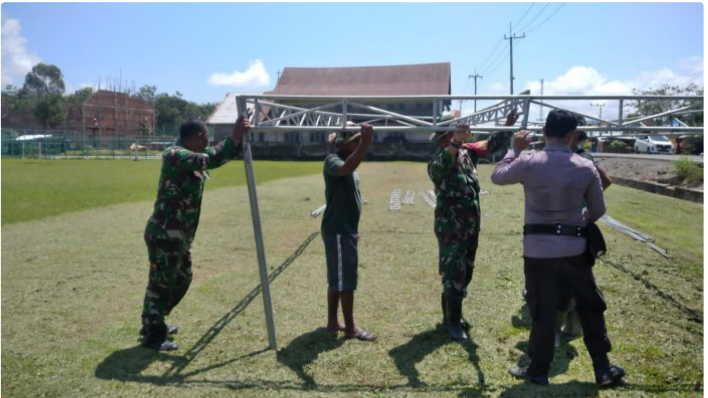
Jelang Penutupan, Satgas TMMMD Ke- 118 Wiltas Kodim 0910/Malinau Siapkan Sarana Prasarana
