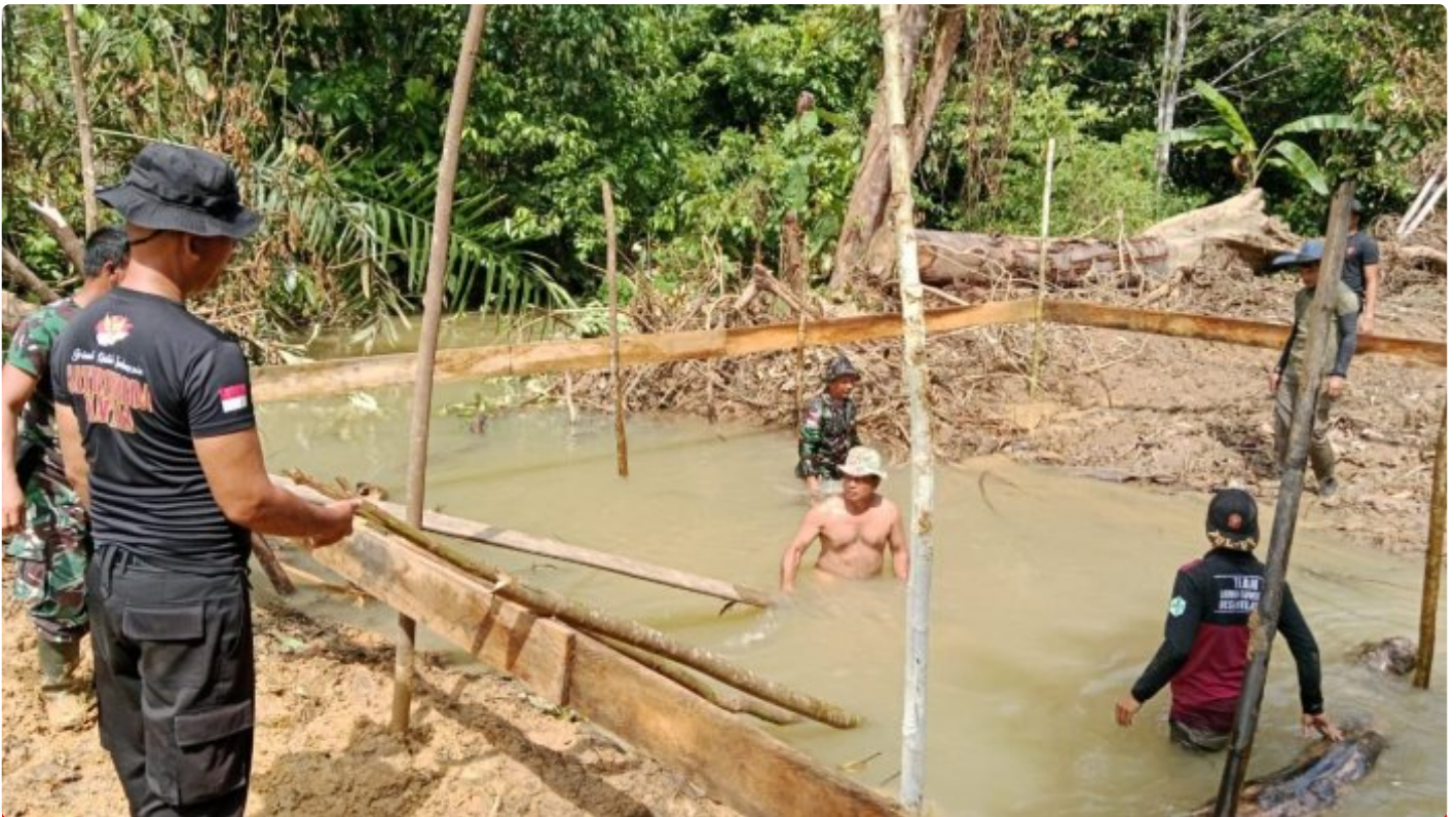
Jebur ke Sungai, Satgas TMMMD ke 118 Kodim 0910/Malinau Pasang Papan Mal Jembatan
